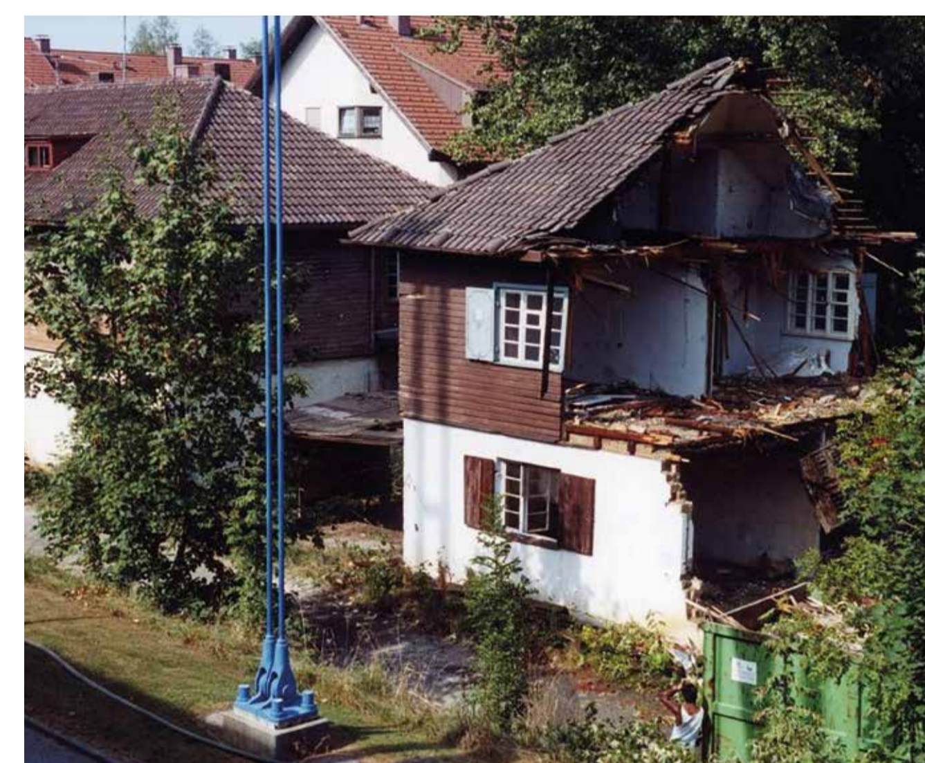
Abbruch der letzten Gebäude des „Unteren Lagers“ östlich des neuen Eisstadions
